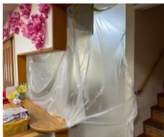
フロアとの境に養生シートを張って作業
